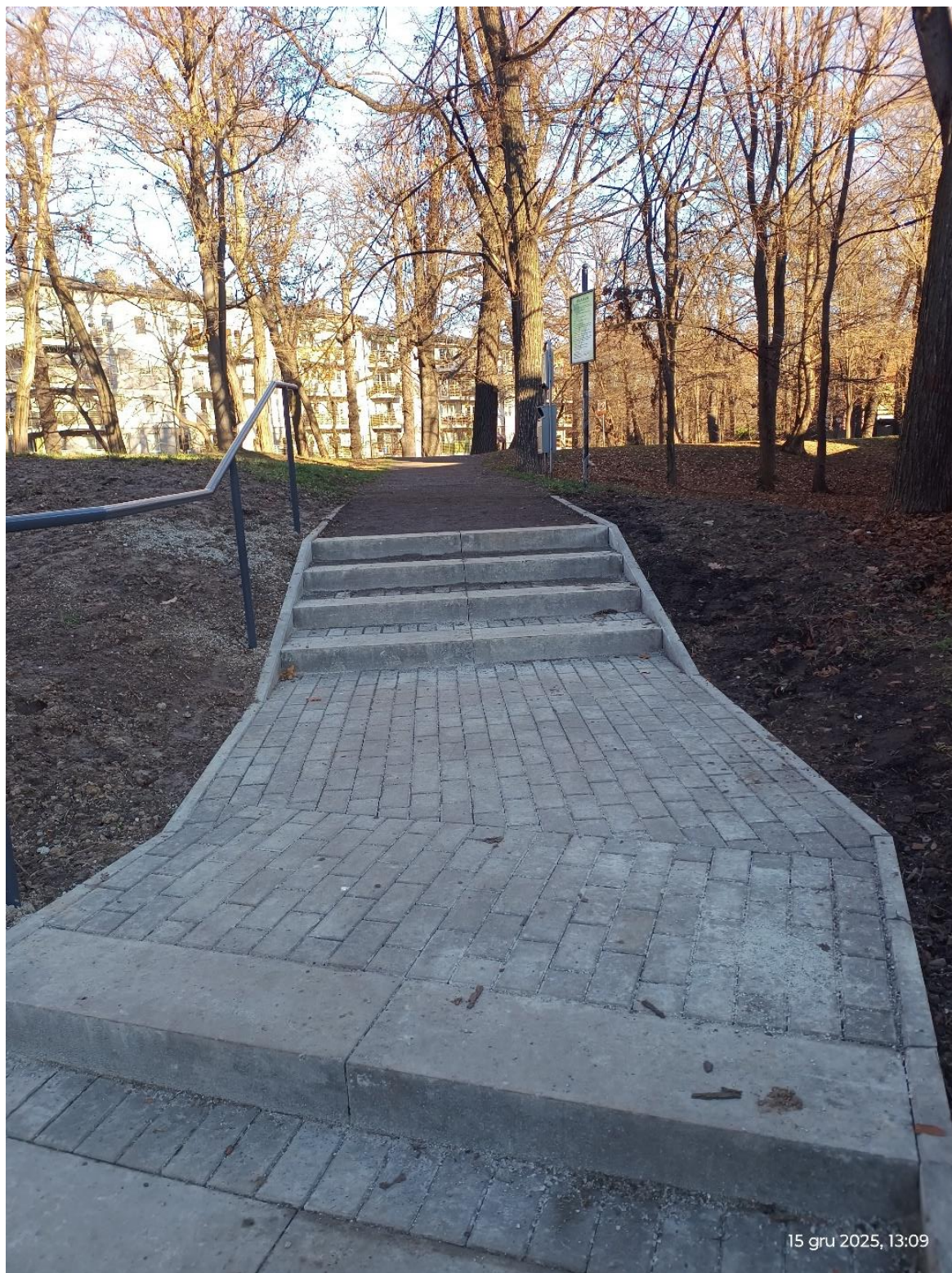
Wyremontowane w roku 2025 roku schody terenowe przy ul. Łukasińskiego
