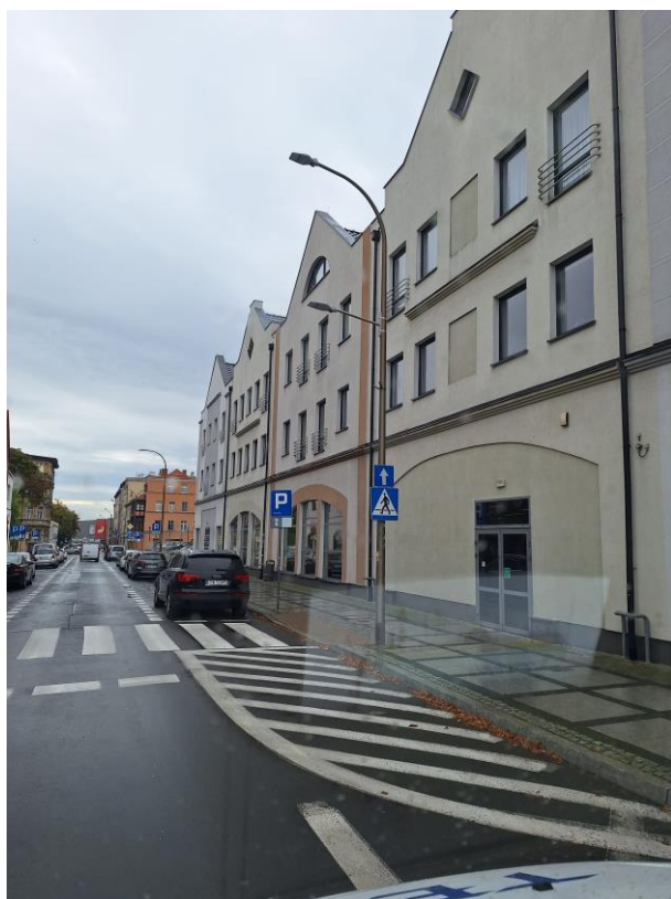
Doświetlone w roku 2025 przejście dla pieszych przy ul. M. Konopnickiej
