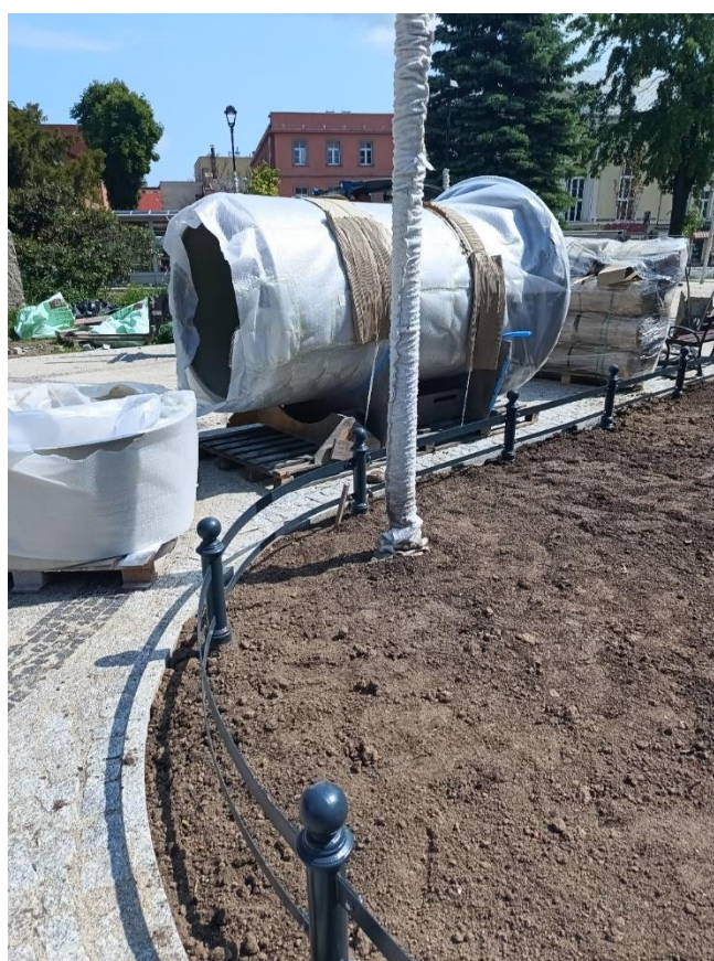
Plac Grunwaldzki w trakcie robót
