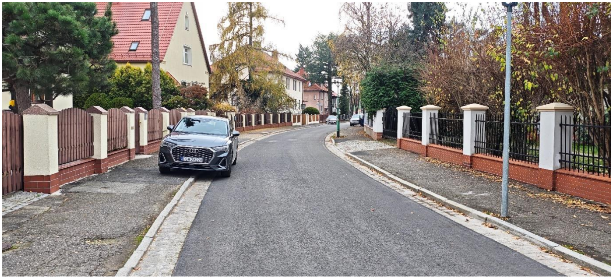
Remont nawierzchni jezdni ul. Fryderyka Chopina
