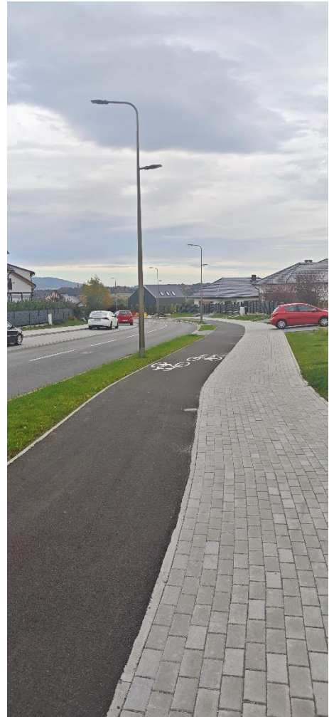
Ul. Sudecka po przebudowie
