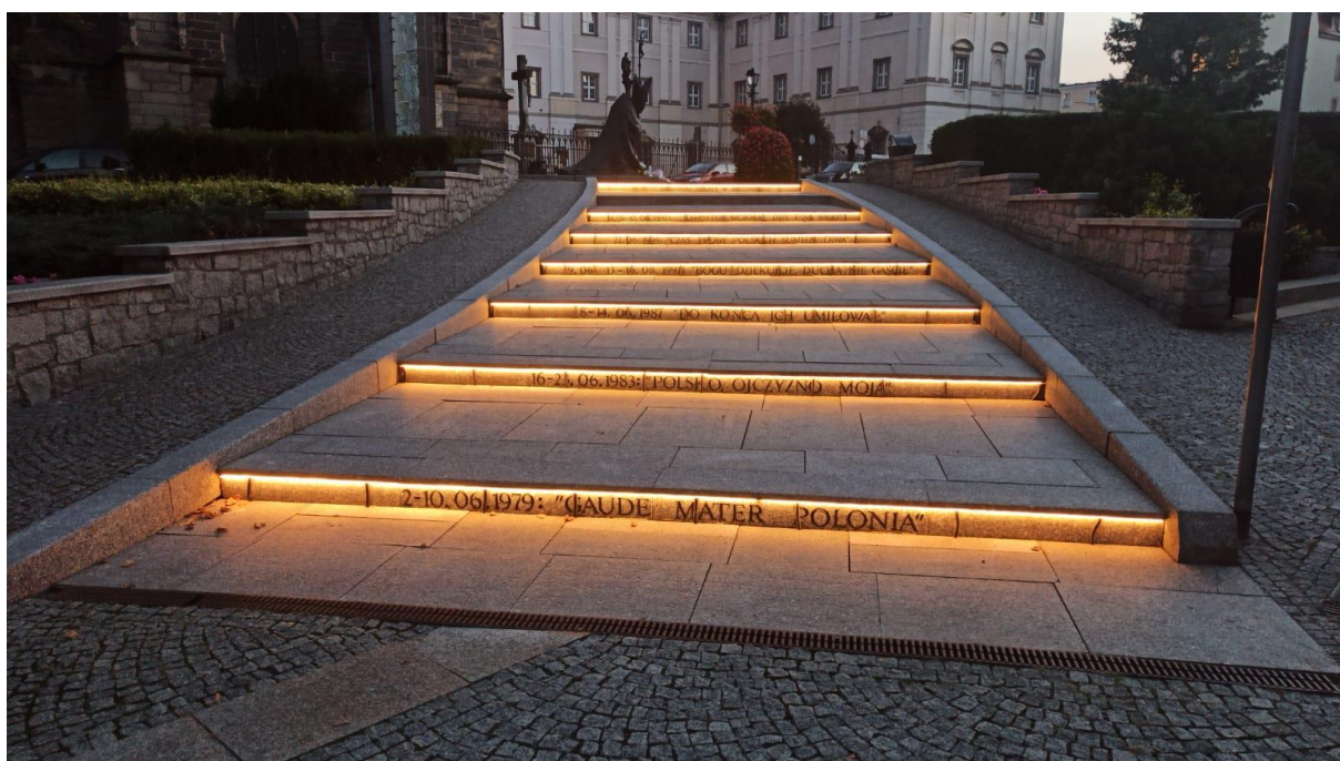
Schody po zakończeniu zadania
