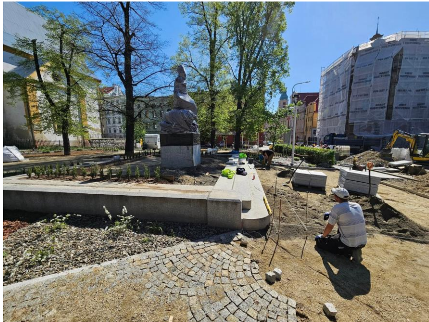
Skwer w trakcie robót
