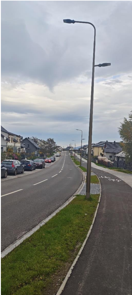
Ul. Sudecka po przebudowie
