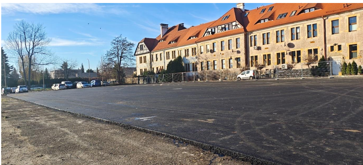
Nowa nawierzchnia asfaltowa miasteczka rowerowego
