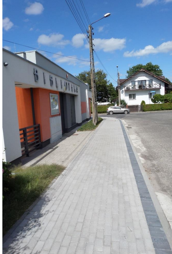
Chodnik wzdłuż ul. Morelowej
