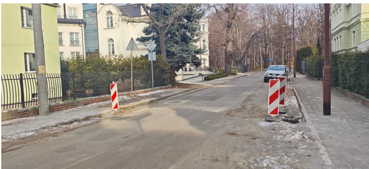
Remont nawierzchni ul. Lwa Tolstoja
