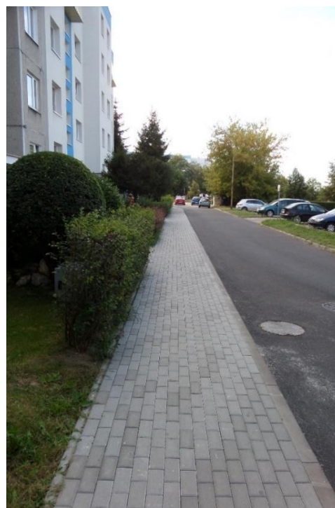
Chodnik wzdłuż ul. Jadwigi Śląskiej
