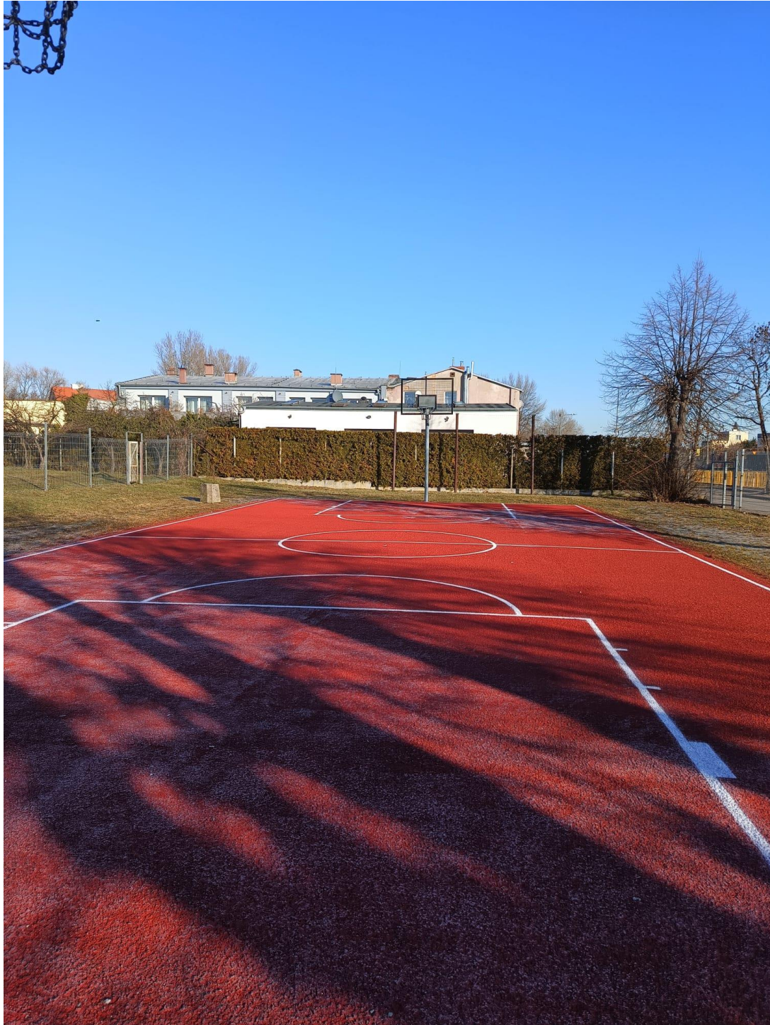
Boisko przy ul. Chłopskiej po remoncie
