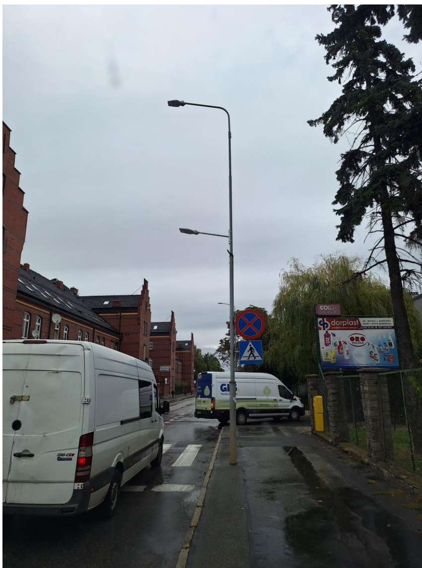
Doświetlone w roku 2025 przejście dla pieszych przy ul. Wałbrzyskiej
