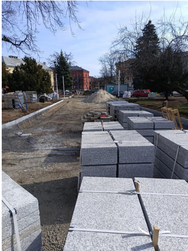
Plac Grunwaldzki w trakcie robót
