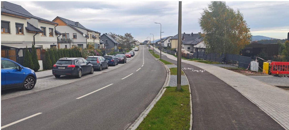
Ul. Sudecka po przebudowie
