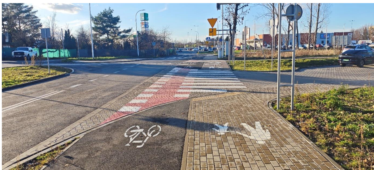
Przebudowa skrzyżowania z ul. Ceglana
